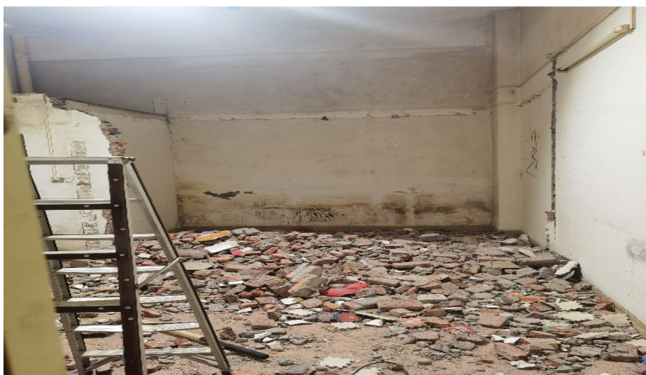
图 3-1：内隔墙 1 拆除后现场情况
