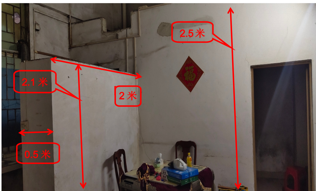
图 2：涉事店铺里间改造前实拍图
